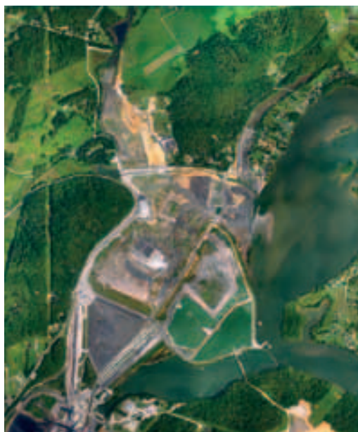
Antes de la rotura del depósito
