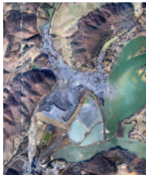
Después de la rotura del depósito
