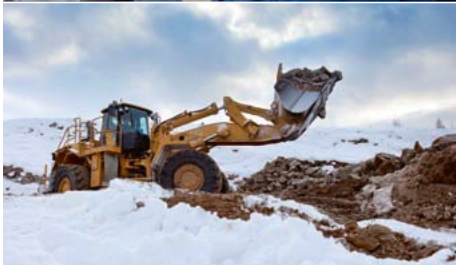
Las palas de ruedas 988H de Cat (arriba) y las motoniveladoras 16H juegan un papel esencial en la construcción y el mantenimiento de los 150 kms de pistas.
