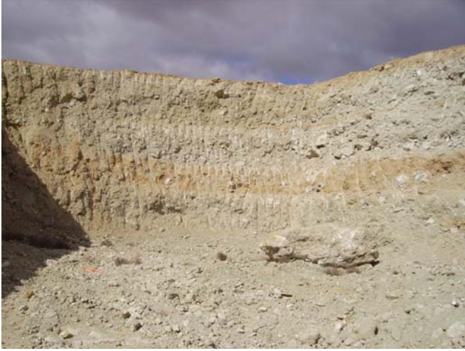
Aspecto de uno de los taludes ejecutado en los rellenos a tratar
