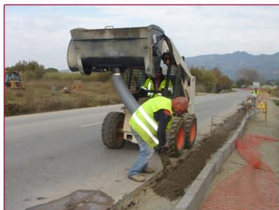
▲ Se descarga con el tubo de vaciado o como cucharón Unloading with discharging tube or as a bucket
